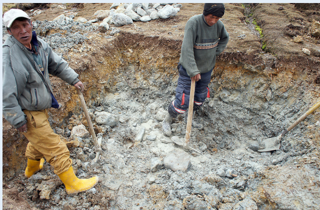
In dem Dorf Altarani ist der Bau der Wasserleitung schon recht weit vorangeschritten. Die einheimische Bevölkerung hebt die nötigen Gräben aus. Foto: LWB/I. Dorji
