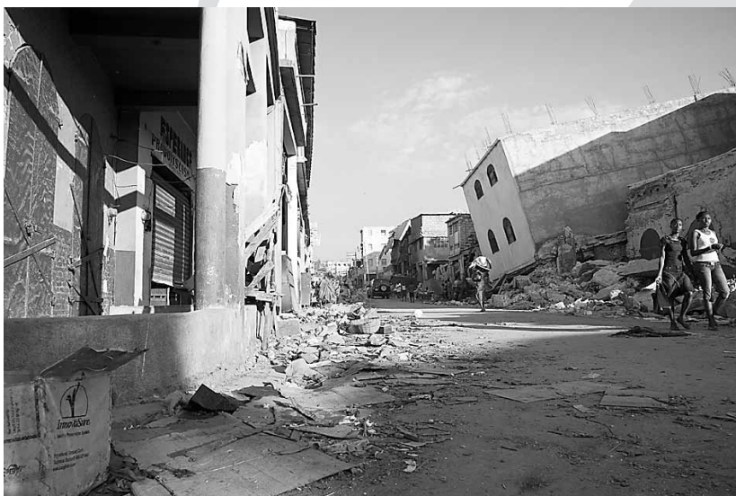
Das Erdbeben hat mehr als 80 Prozent des Gebietes von Port-au-Prince wie auch diesen Teil des Zentrums zerstört. © ACT-Bündnis/Paul Jeffrey
